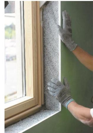
Facile à mettre en œuvre, l'isolation intérieure des murs peut être réalisée pièce par pièce. Par ailleurs, elle supprime l'effet paroi froide et permet de respecter l'architecture extérieure en conservant à l'identique les façades travaillées (moulures, colonnes...).
