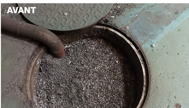
Nettoyage d'une retenue sur regard
