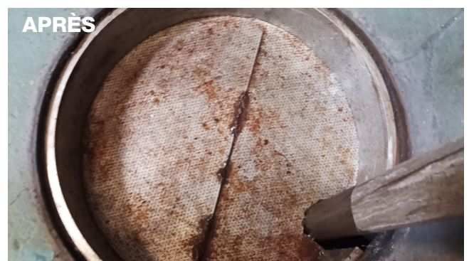
Nettoyage d'une retenue sur regard
